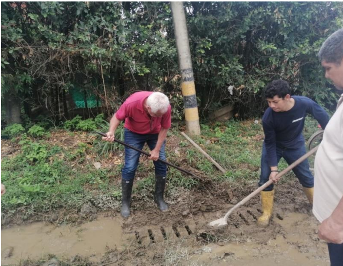
Limpieza de canal para drenaje de vía inundada
